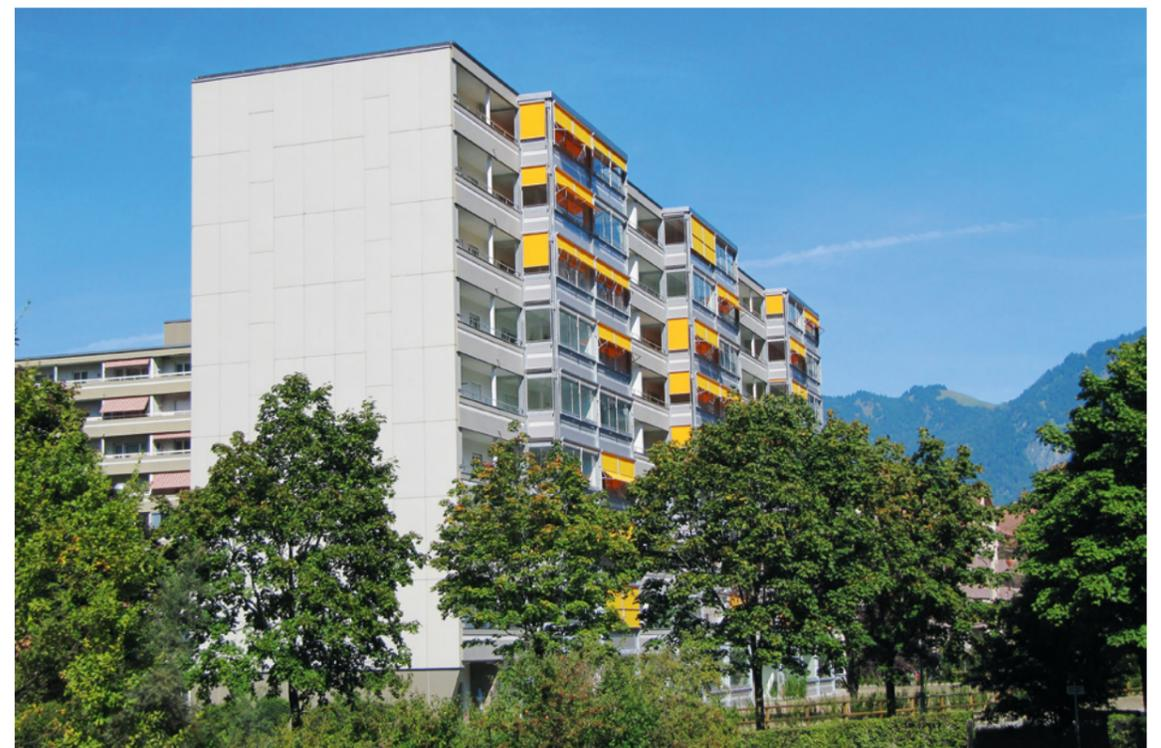
MFH Scalettastrasse 119, 121 und 123. Auch an der Scalettastrasse wurde mit dem verglasten Balkenteil (Bild oben) zusätzlicher Wohnraum von etwa 12m<sup>2</sup> geschaffen.
